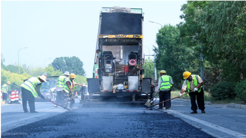
工程现场。 陈龙 图
